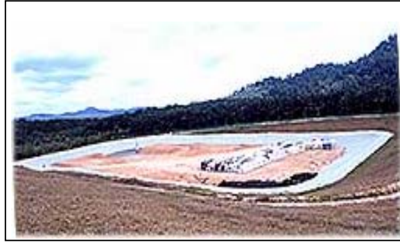
Rajah 2. Kawasan pembuangan sisa berjadual di Bukit Nanas Negeri Sembilan. Gambar menunjukkan penyediaan tapak pelapik tanah yang bertujuan menghalang pencemaran alam sekitar.
